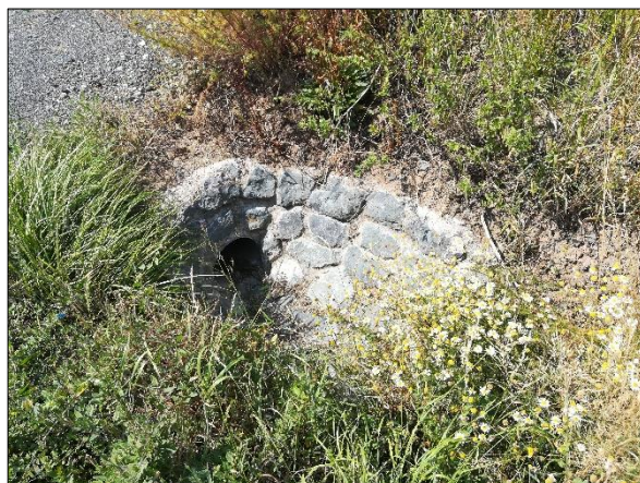
Abb. 10: Verrohrter Graben mit Begleitflora.
