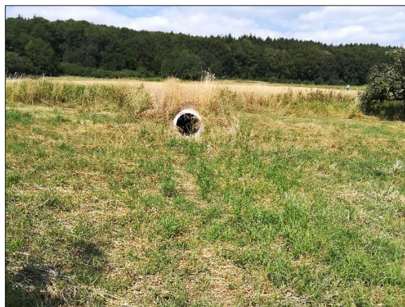
Abb. 11: Verrohrter Graben, Blick nach Südwesten.
