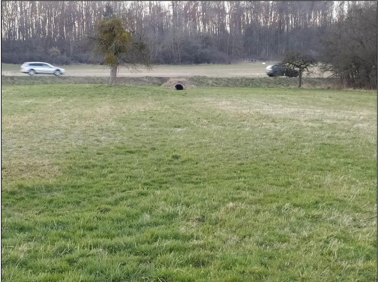
Abbildung 6: Seebachverrohrung unter der Landesstraße (Westabschnitt): hier ist aktuell kein Bach vorhanden
