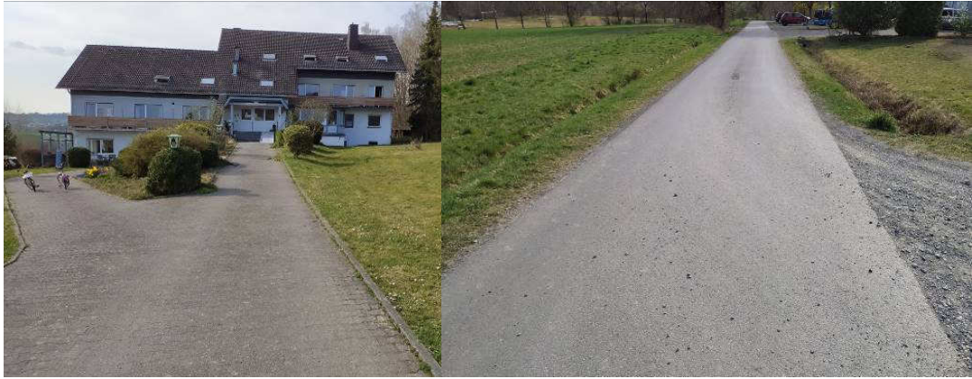
Abbildung 8+9 Gebäude und Straße als vollversiegelte Fläche (eigene Aufnahme im März 2022)
