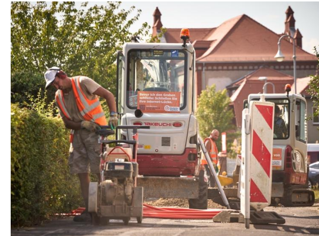
Große Fortschritte beim Glasfaserausbau in Mengerskirchen
